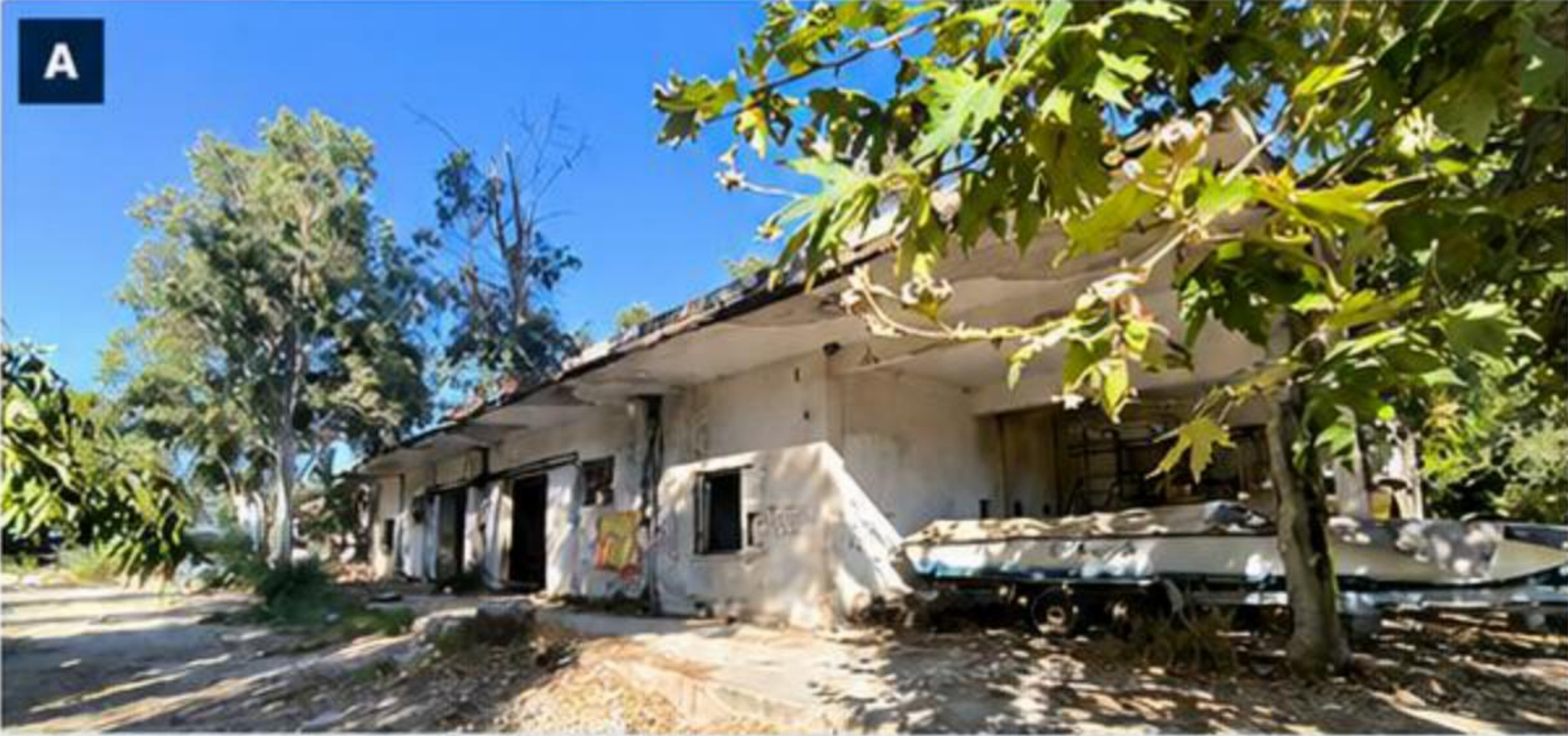
A. Υφιστάμενο κτίσμα (μακρόστενο κτίριο)
